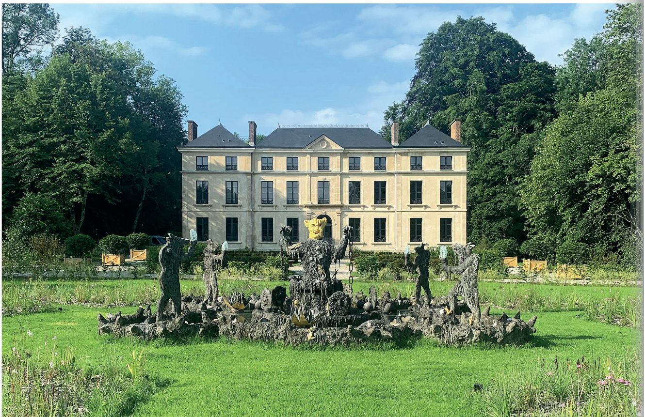
Château La Résidence - LeTremblay. Rénovation en cours/ongoing renovation. (Ph. Christophe Gaillard)
